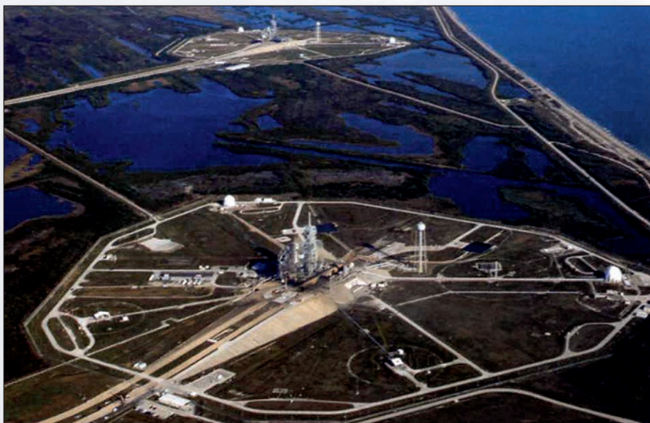
Две стартовых площадки LC-39A и LC-39B для запусков шаттлов. На каждой из них размещается стартовый стол, ангар для оборудования, хранилища компонентов топлива и сжатых газов, ресиверные системы газоснабжения, контрольно-проверочная аппаратура, узел связи, убежище для космонавтов и испытателей и т.п. Убежище представляет собой куполообразное помещение диаметром 12 м, рассчитанное на 20 человек и защищенное стальными плитами толщиной 0,9 м. В случае аварийной ситуации космонавты и обслуживающий персонал попадают в убежище на глубину 12 м, скользя по наклонному желобу со скоростью 20 м/с. Для экстренной эвакуации обслуживающего персонала с кабель-заправочной башни стартовое сооружение оборудовано канатной дорогой с подвесной кабиной. Спуск на землю обеспечивается за 30 с.
